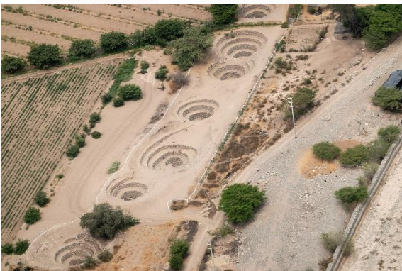
Figure 7 – Aqueducs de Cantalloc ; Nazca, Pérou
