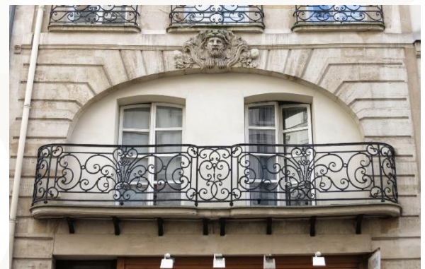
Figure 19 – Détails de la ferronnerie du balcon, 42 rue François-Miron ; Paris, France
